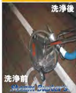
専用のトラックマウント車による高温・高圧でのスピンバック洗浄です。洗浄後、素早く汚水を回収することにより浸透しやすいインターロッキングにおいても汚れの再付着がありません。
