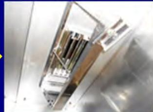
フード内の器具は脱着洗浄（一部脱着不可の場合あり）。グリスフィルターは分割タイプの場合、分解洗浄。その他、制気口（HS、VHS）・天井扇もご要望により施工。
