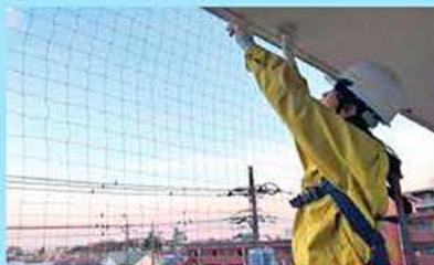
工事スタッフによる、取付イメージ。
