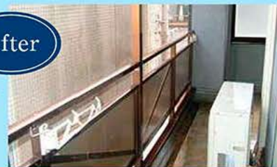
バードネット取付後。
