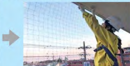
工事スタッフによる、取付イメージ。
